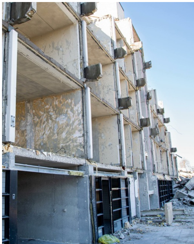
Vollsmoseblok under nedrivning.
